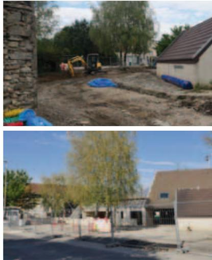
Le chantier a pris sa place, la clôture a été posée tout autour pour assurer la sécurité des usagers des espaces voisins et la protection des installations. Le préau en bois a été déposé. Les réseaux enterrés ont été posés dans la cour. Une partie du bâtiment existant a été démolie pour permettre la construction de l'extension.
