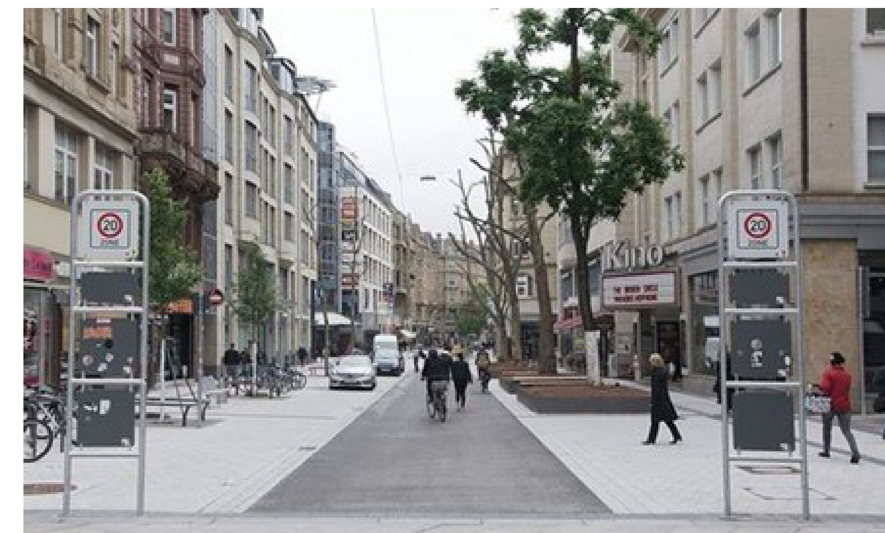
Faciliter la cohabitation de tous les modes de déplacement en réduisant le différentiel de vitesse entre piétons, voitures et vélos
